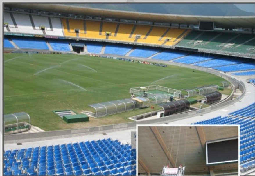
Manutenção do antigo estádio do Maracanã (2007 a 2011)
