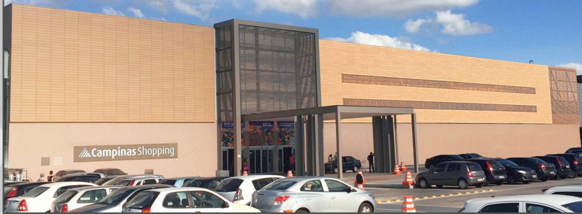
Shopping Campinas (SP): Sistema de revestimento independente em fachada ventilada cerâmica extrudada (2015).
