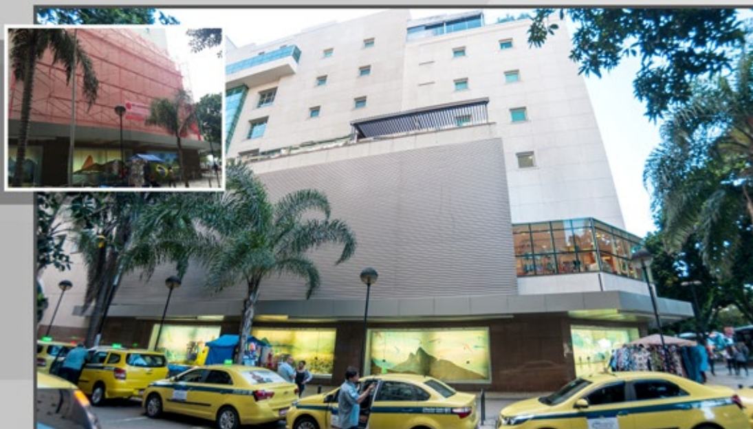
Retrofit de fachada Botafogo Praia Shopping (2014)
