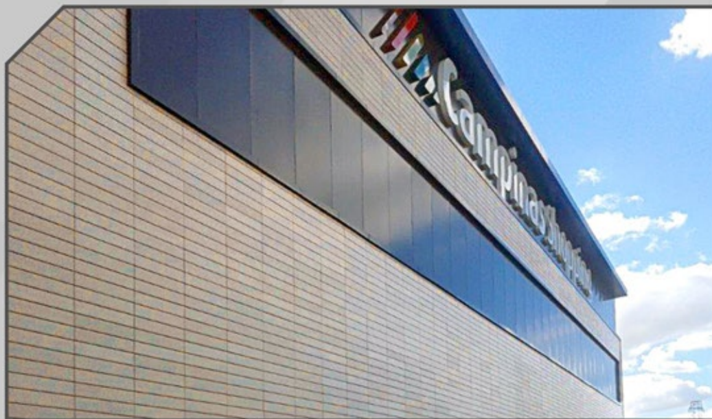
Shopping Campinas (SP): Sistema de revestimento independente em fachada ventilada cerâmica extrudada (2015).
