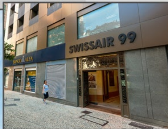
Ed. Swissair, Centro do Rio: Retrofit com sistema de revestimento independente, adequações de instalações elétricas, hidráulicas e estruturais (2017).
