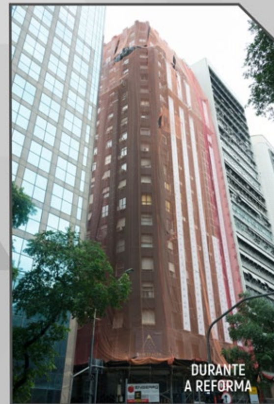
Ed. Swissair, Centro do Rio: Retrofit com sistema de revestimento independente, adequações de instalações elétricas, hidráulicas e estruturais (2017).
